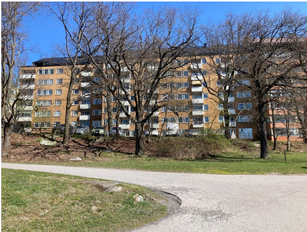
Bild 11. Foto från planområdet mot fastighetens västra fasad. Föreningens fastighetsgräns går i linje med parkeringen och staketet.
